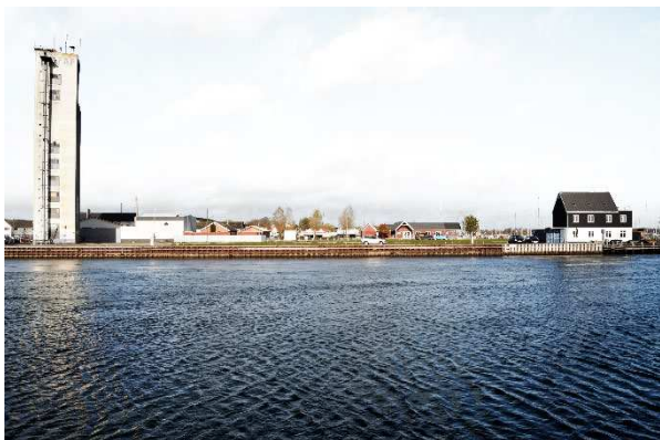
Eksisterende forhold set fra syd.
